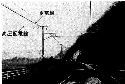
写真5.2 鉄道の高圧配電線
